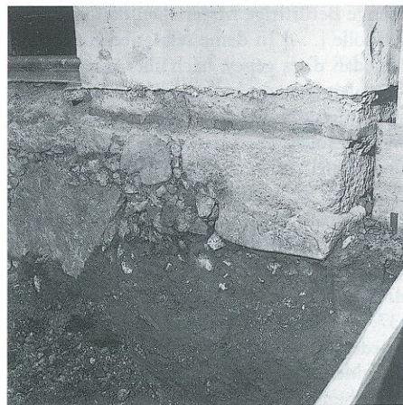
Abb. 13a/b: Fundamentmauerwerk innen: Steinsetzung mit Ziegellagen (Fotos: R. Gobiet).
