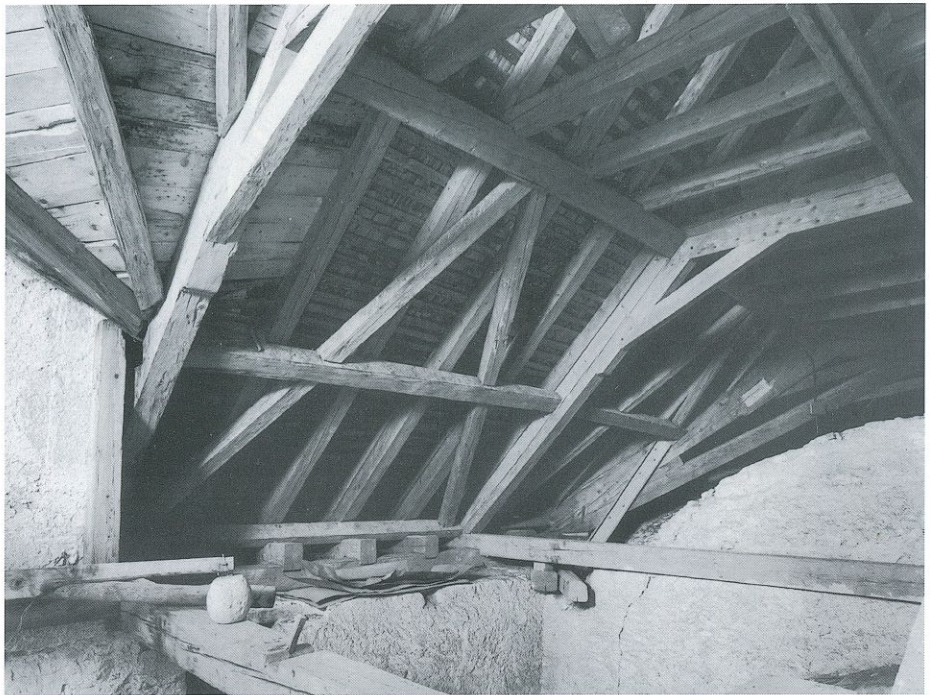
Abb. 12: Detailansicht des Dachstuhl der Wallfahrtskirche Maria Kirchenthal.
