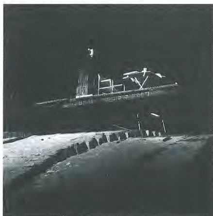
Abb. 5 Versprünge der Gewölbeshale über dem Chor mit Wartesteinen. Blickrichtung nach Norden zum Kuppeltambour.
