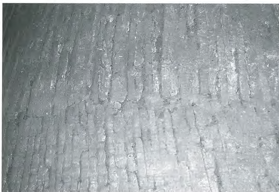
Abb. 15 Die Überwölbung des Fassadenbaukörpers setzt am Tonnengewölbe des Langhauses unter der nördlichsten regulären Binderachse des Dachwerkes mit einer deutlichen Nahtstelle an. Diese Baufuge ist gekennzeichnet durch einen Wechsel der Technik (am Tonnengewölbe signifikantes Tiefersitzen der Binderlagen gegenüber den Läuferlagen, an der Kalotte ebene Oberfläche) sowie des Ziegelformates (die Ziegel der Kalotte sind etwas niedriger); die Naht verläuft relativ regelmäßig und ohne Wartesteine. Die ‚Kalotte‘ führt zunächst die Höhenebene der Tonne weiter; ein 150 cm breiter Streifen nördlich des Anschlusses ist noch als Tonnenstreifen gemauert. Erst an diesen setzt, nach einem glatt verspringenden Absatz von 17 cm Höhe, das in Ringlagen gemauerte eigentliche Kalottengewölbe an. Ein Druckring existiert nicht; die Lagen sind, verglichen mit dem Gewölbe der Apsiskalotte, grob gezogen. Ähnlich improvisiert wie die Kalotte wirkt der Anschluß des Attika-Mauerwerks an die Sargwand des Langhauses; ob die dortigen Anflickungen jedoch als echte Baunaht betrachtet werden können, muß angesichts des insgesamt sehr unregelmäßigen und durch den Grobputz verunklärten Mauerwerksbildes offen bleiben 21 .
