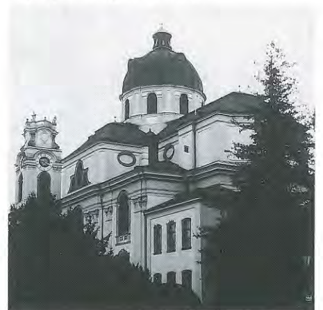
Abb. 7 Chor und westliches Querhaus. Die Okuli in der Hochschiffwand (Sargmauer) sind Teil der Außengliederung des Bauwerks.
