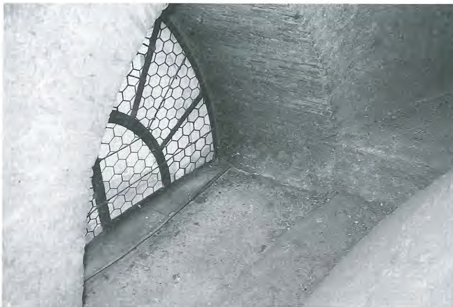
Abb. 14 Östliches Ovalfenster der Fassadenattika von innen. Rechts unten angeschnitten die Kalottenwölbung.
