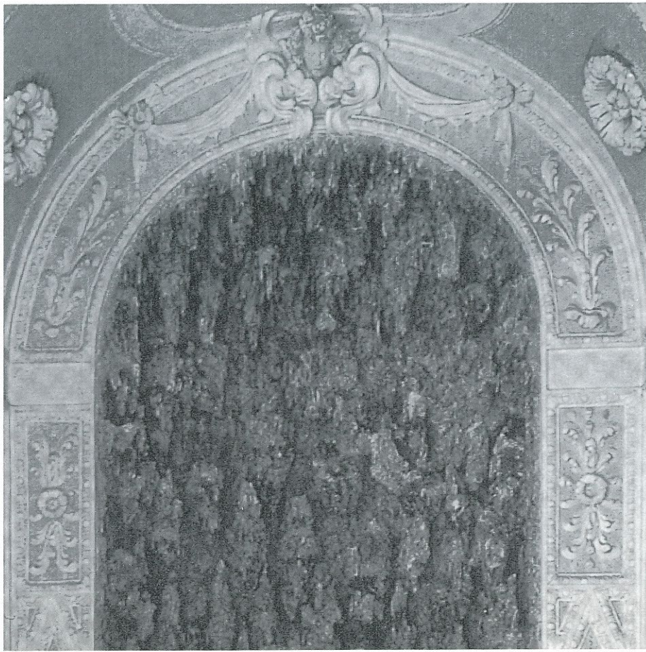
Abb. links: Oberer Teil der Wandgestaltung des Herkulesbrunnens im Haupthof der Residenz mit Tittmoninger „Röhrl-Tuff“.
